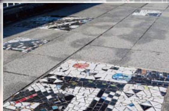
多治見橋歩道のタイル
